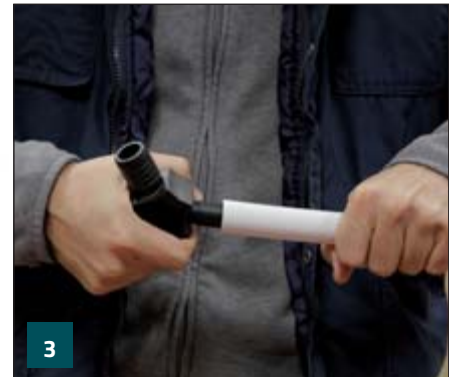
3 Calibrar y escarear la tubería.
