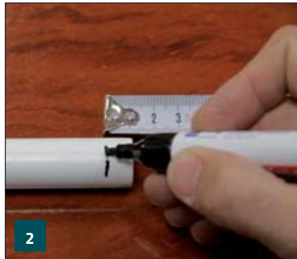
2 Marcar la profundidad sobre el tubo a introducir en la matrices. (Profundidad = 1 cm).
