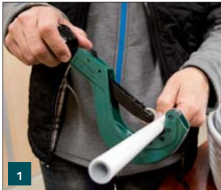
1 Cortar perpendicularmente al eje del tubo.
