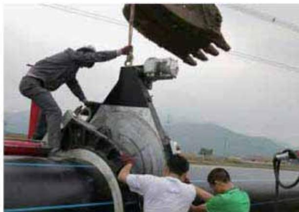
Revestimiento antideslizante y fractura de tubería con larga longitud de tubería de PE proveen alteraciones mínimas a los sistemas existentes de agua y alcantarillado, y a la comunidad local.
