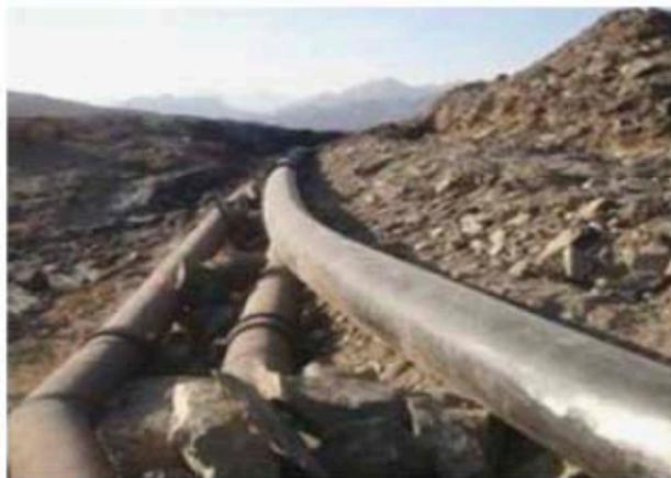
La tubería de PE es ampliamente usada en aplicaciones sobre la tierra, particularmente en condiciones exigentes típicas de zonas de minas y rurales.
