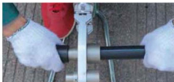
5. Tirar de la tubería y del accesorio de los elementos calentadores, y juntarlos hasta toda la longitud marcada sin distorsionar la unión. Sujetar la unión y esperar hasta que esté totalmente fría. El cordón de soldadura debería aparecer alrededor de la circunferencia del extremo del accesorio.
