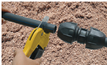
1. Cortar el tubo.
