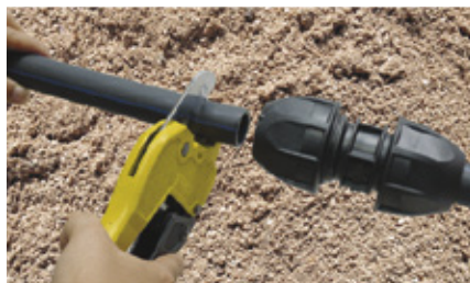
1. Cortar el tubo.
